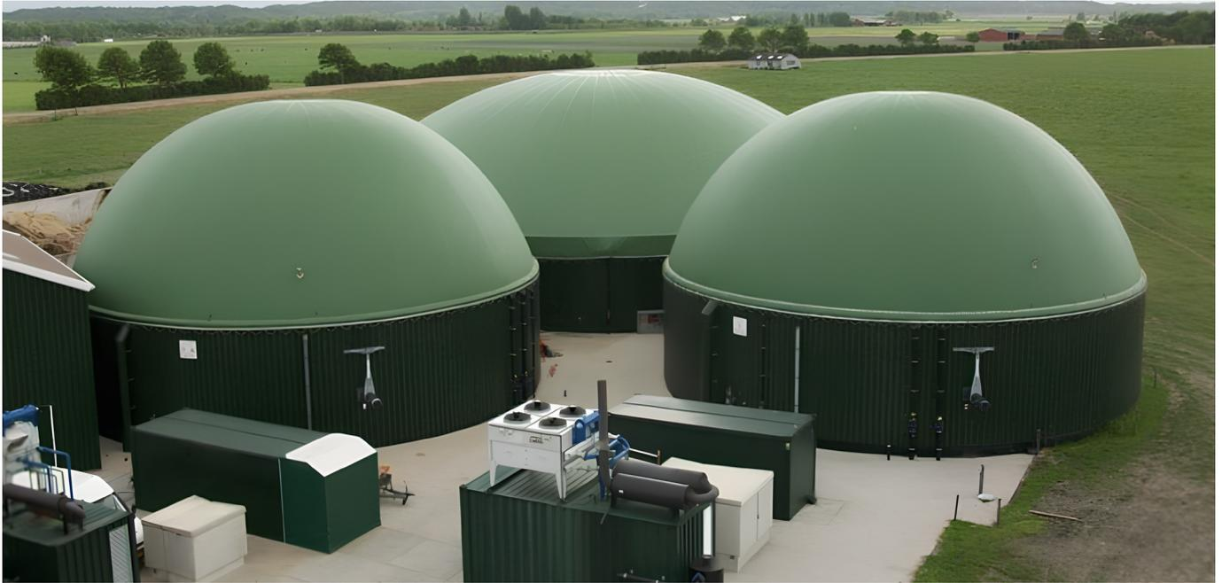
**Photo de 2 digesteurs (gauche et droite) et le stockage du digestat au centre**
